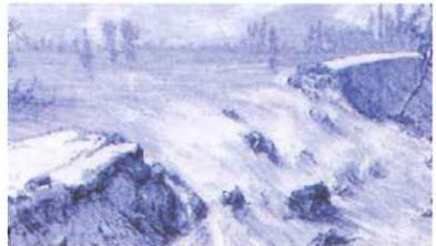
Rupture d'une digue au 19 ème siècle. Lors de la crue de 1856, 160 brèches sont comptabilisées entre Nevers et Nantes. Source : DIREN Centre
